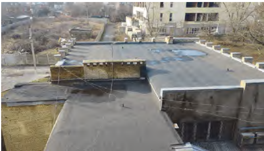
Рисунок 8.13 – Відремонтована м'яка покрівля будівлі
