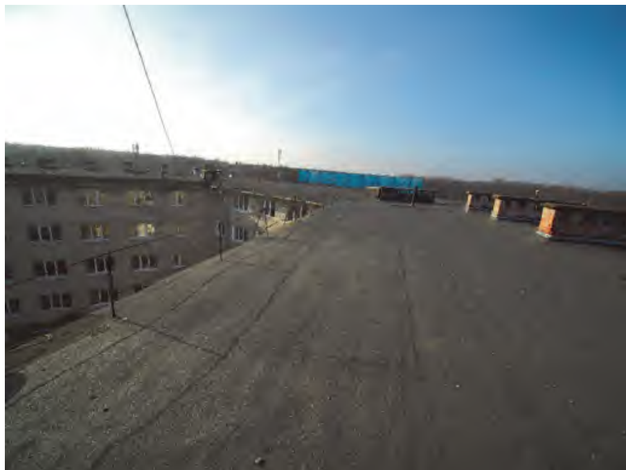
Рисунок 8.12 – Відремонтована м'яка покрівля гуртожитків № 7
