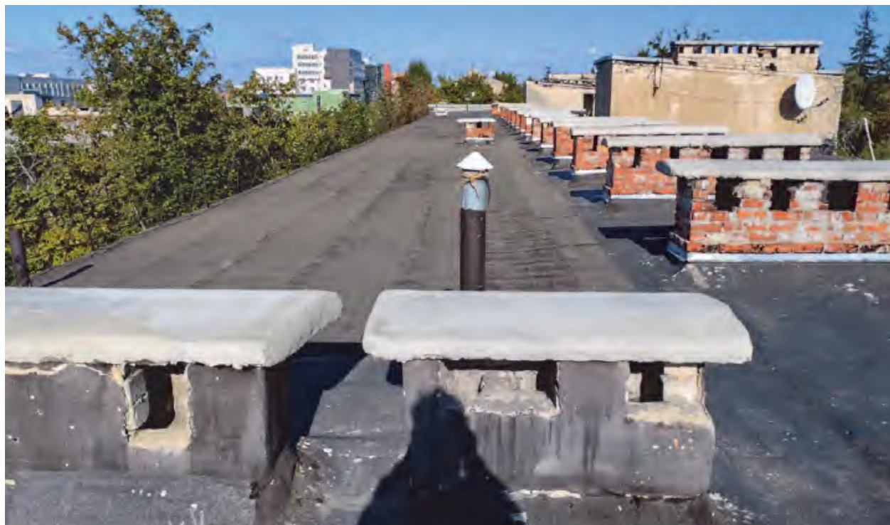
Рисунок 8.16 – Відремонтовані оголовки вентиляційних каналів
