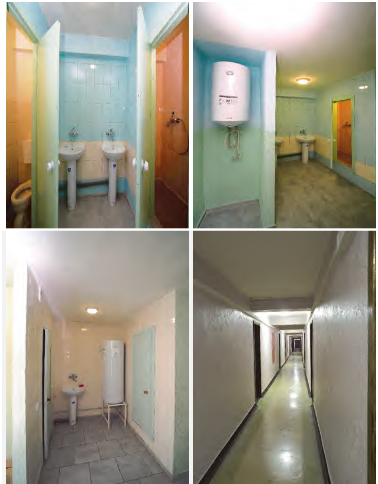
Рисунок 8.9 – Відремонтовані господарські приміщення гуртожитків
