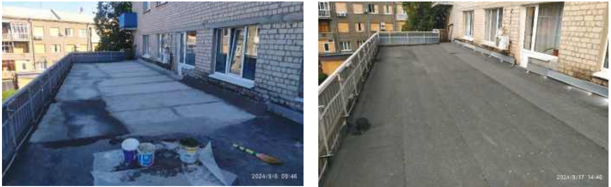
Рисунок 8.15 – Ремонт м'якої покрівлі
