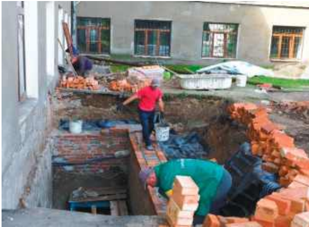
Рисунок 8.9 – Ремонт приямків та фасадів
