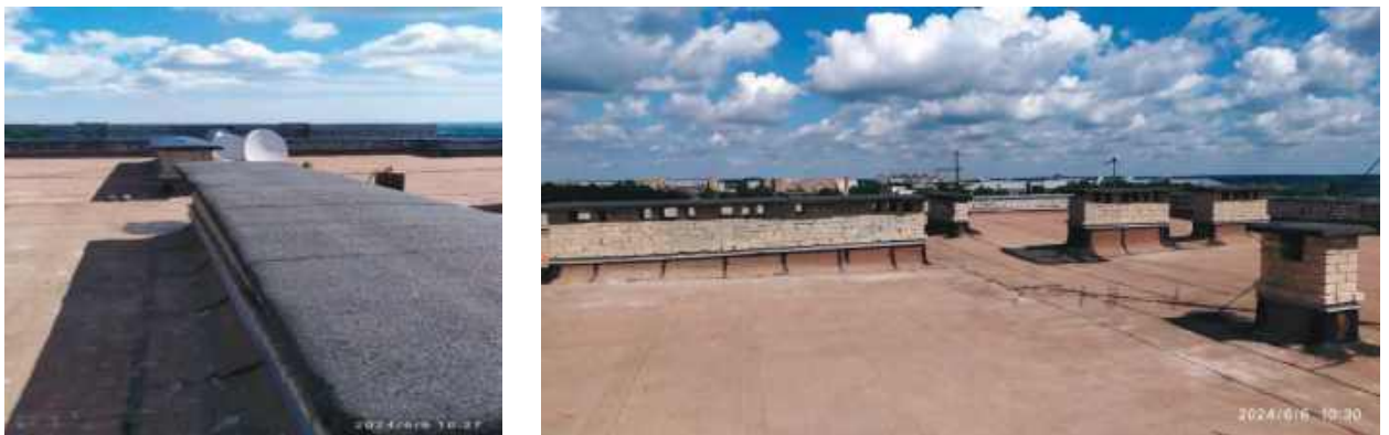
Рисунок 8.16 – Ремонт покрівлі житлових будинків
