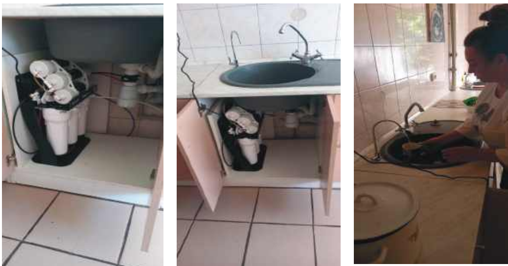
Рисунок 8.19 – Осмаси для очищення води
