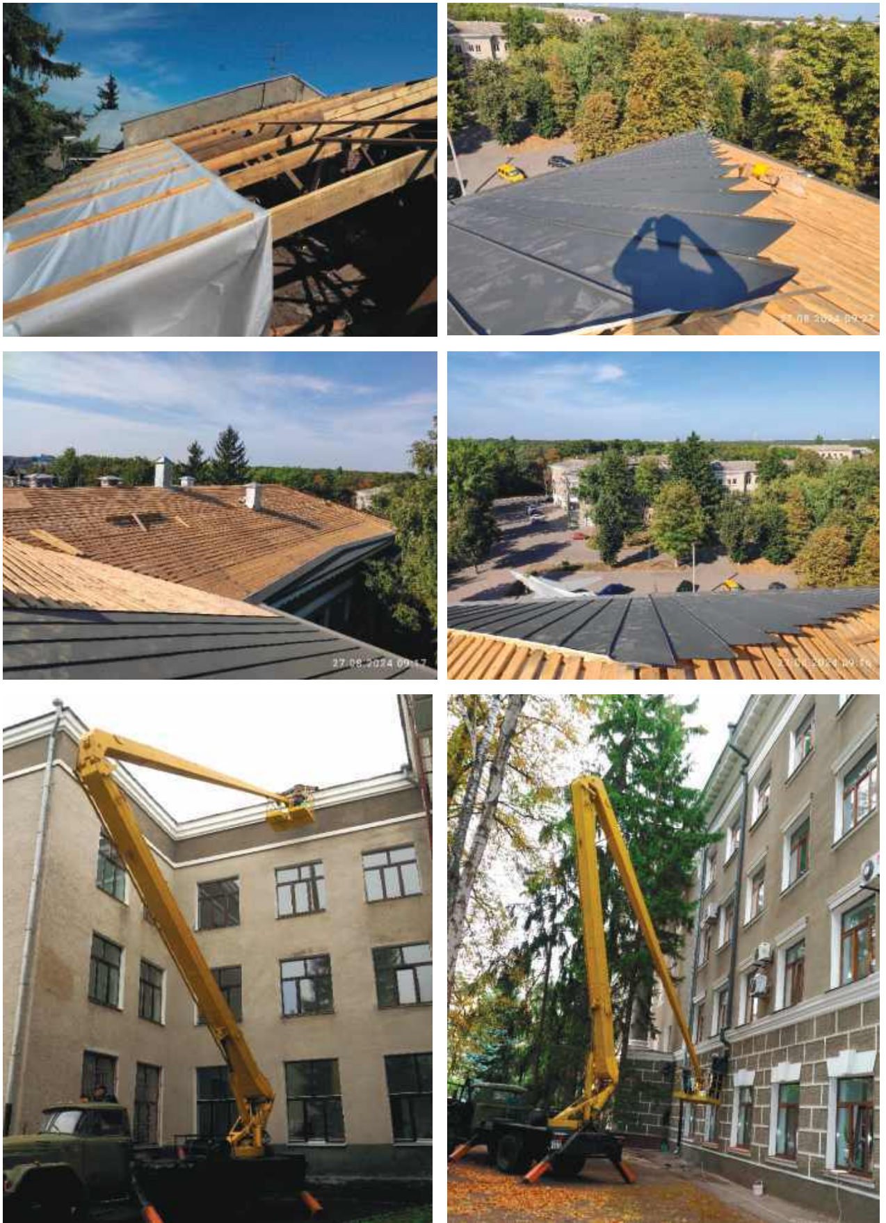
Рисунок 8.7 – Покрівля головного корпусу
