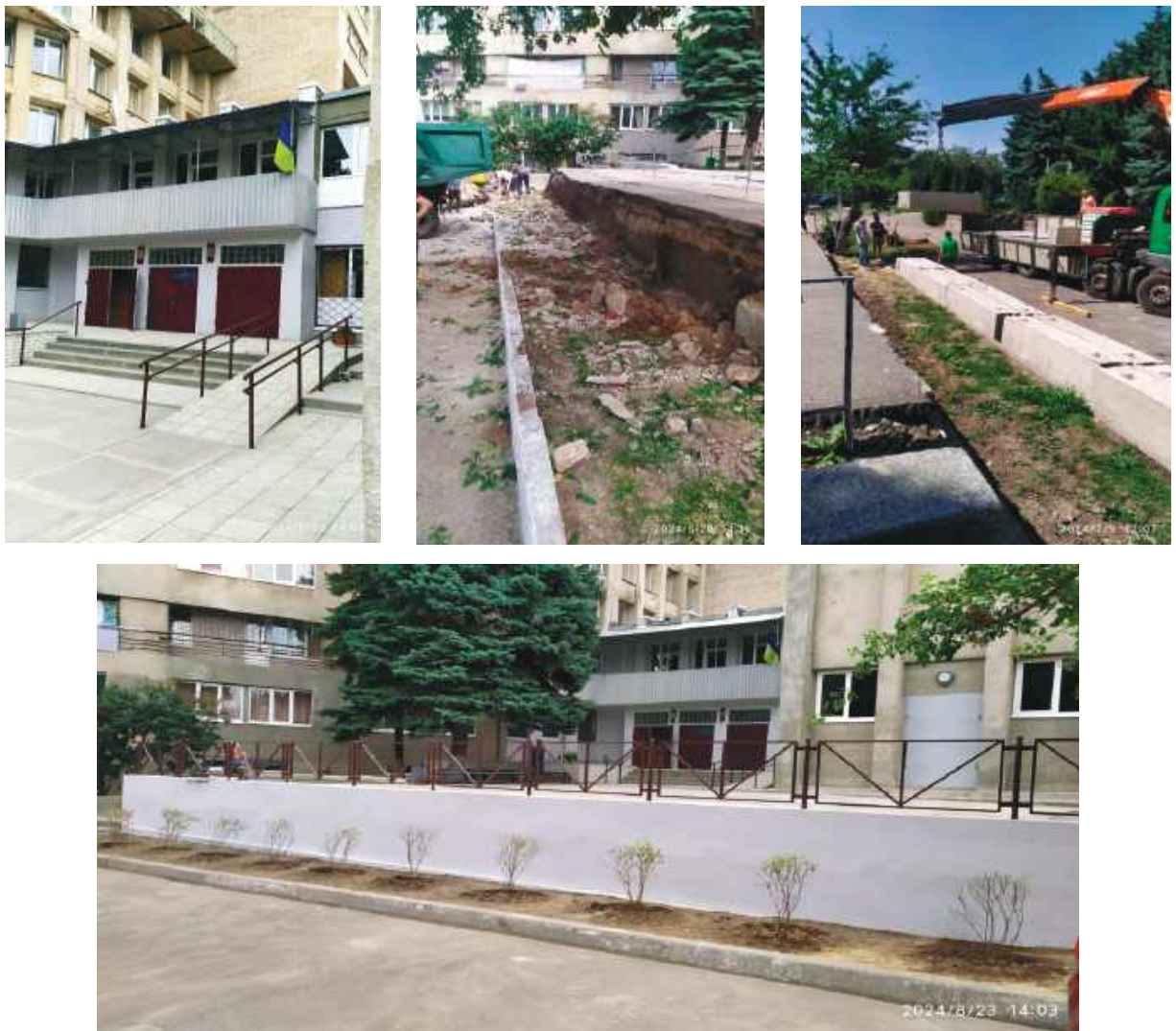
Рисунок 8.14 – Ремонт сходинок та площадок біля гуртожитків
