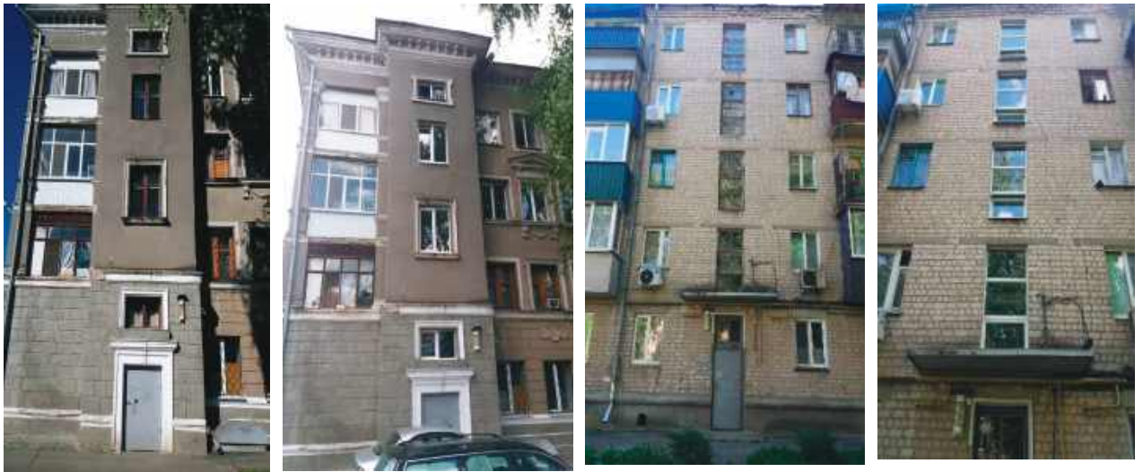
Рисунок 8.22 – Заміна вікон на під'їздах житлових будинків
