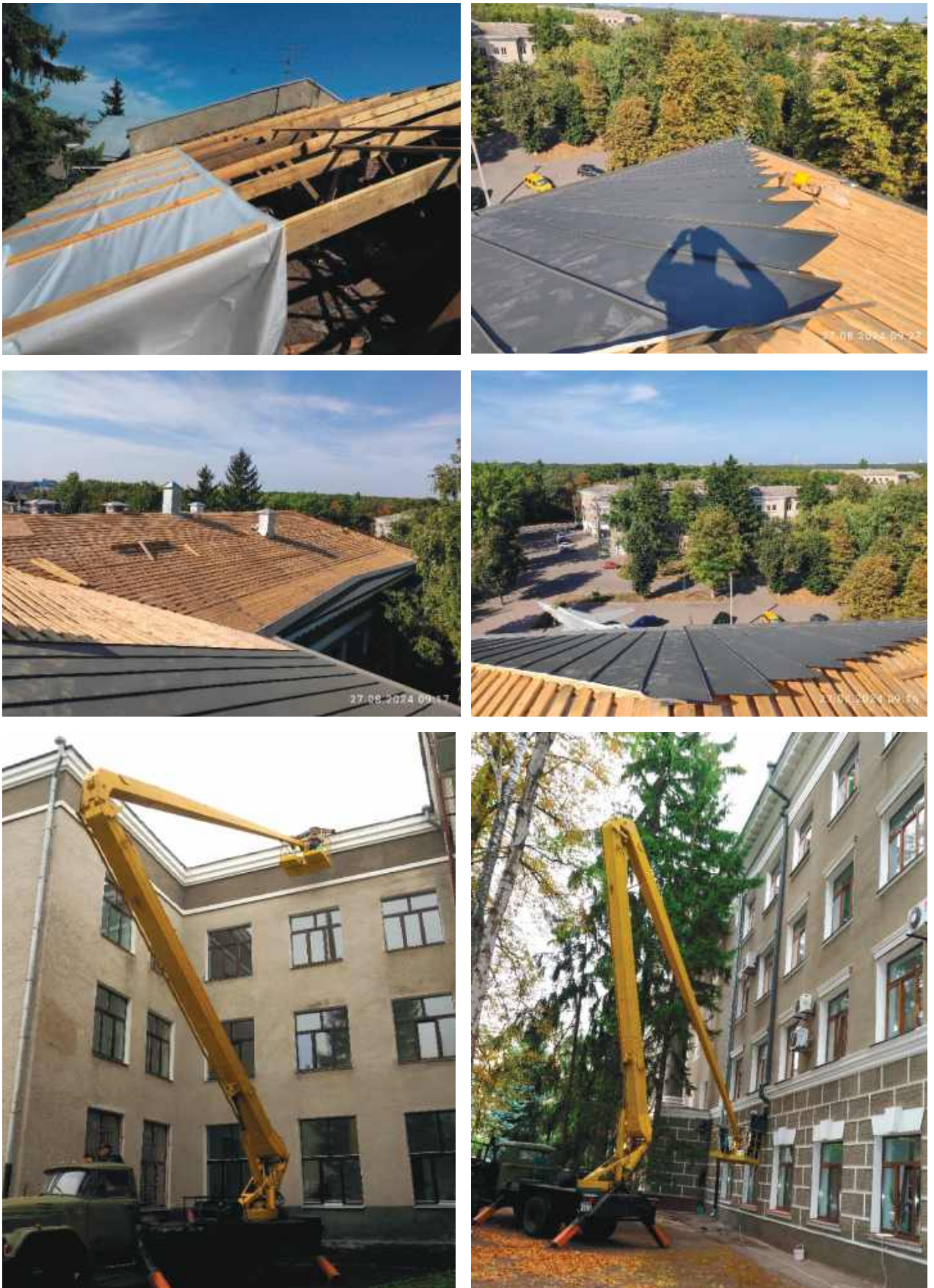
Рисунок 8.7 – Покрівля головного корпусу
