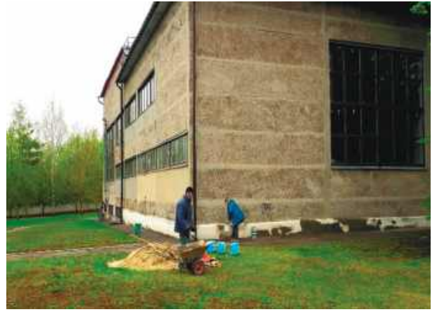
Рисунок 8.9 – Ремонт приямків та фасадів
