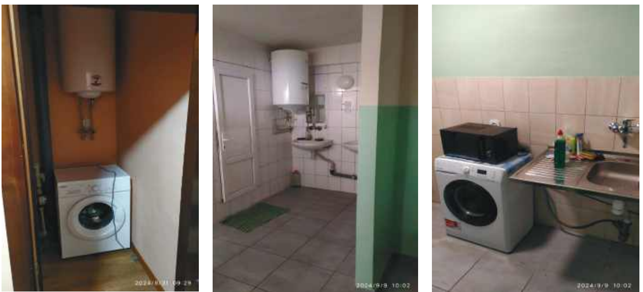
Рисунок 8.13 – Відремонтовані побутові й туалетні кімнати
