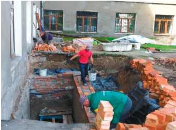
Рисунок 8.9 – Ремонт приямків та фасадів
