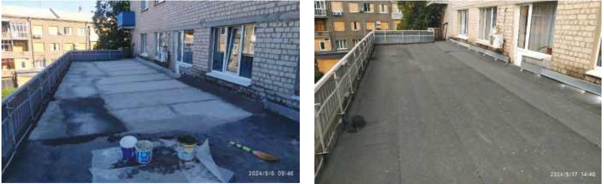
Рисунок 8.15 – Ремонт м'якої покрівлі
