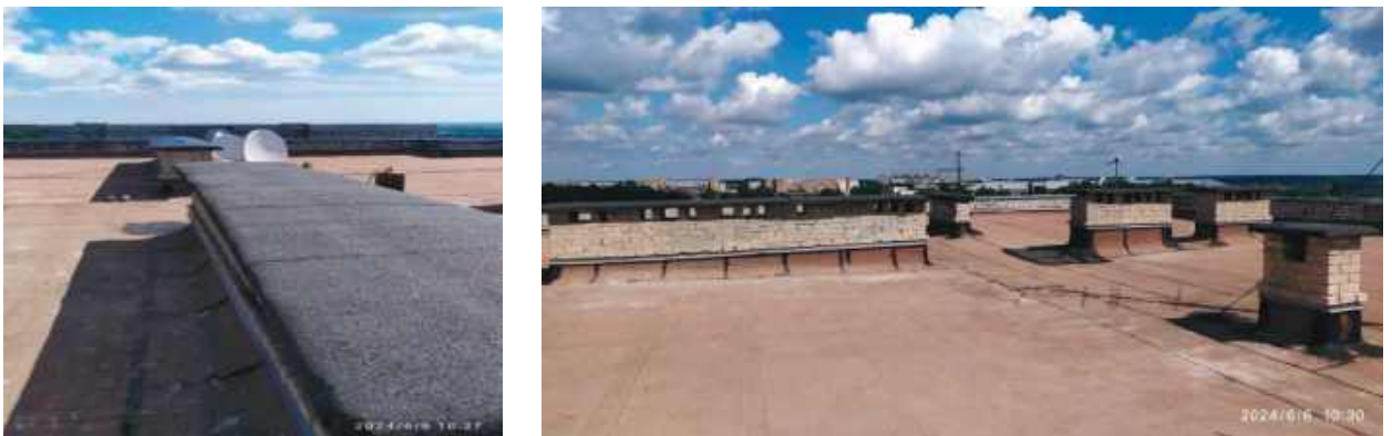
Рисунок 8.16 – Ремонт покрівлі житлових будинків
