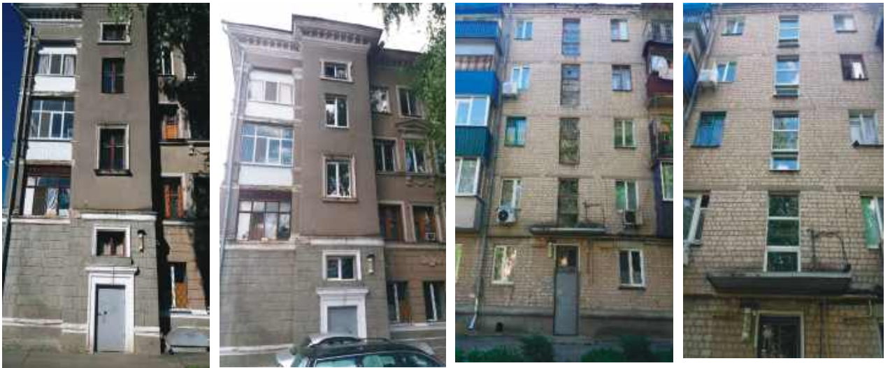
Рисунок 8.22 – Заміна вікон на під'їздах житлових будинків
