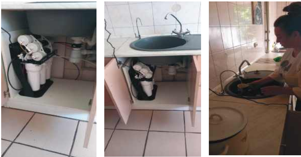
Рисунок 8.19 – Осмаси для очищення води
