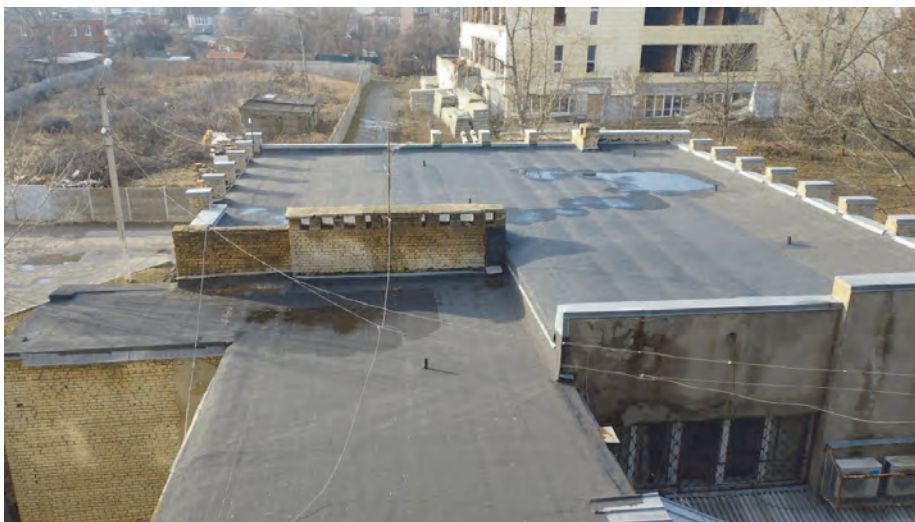
Рисунок 8.13 – Відремонтована м'яка покрівля будівлі
