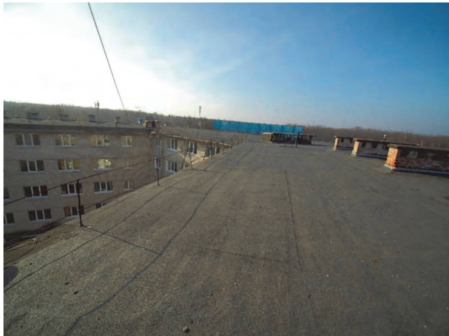
Рисунок 8.12 – Відремонтована м'яка покрівля гуртожитків № 7
