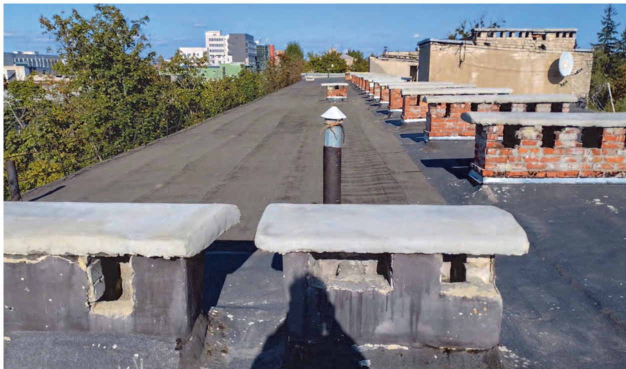
Рисунок 8.16 – Відремонтовані оголовки вентиляційних каналів
