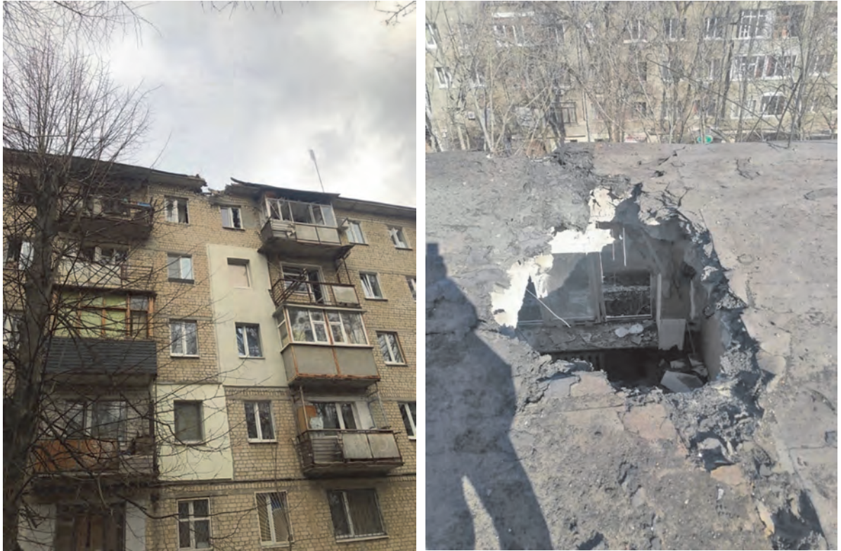
Рисунок 7.15 – Житловий будинок вул. Чкалова, 13
