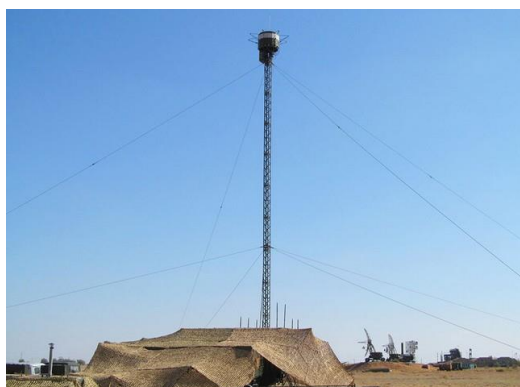
Рисунок 1.9 – Зовнішній вигляд антенної системи РЛС "Роса-РБ"
