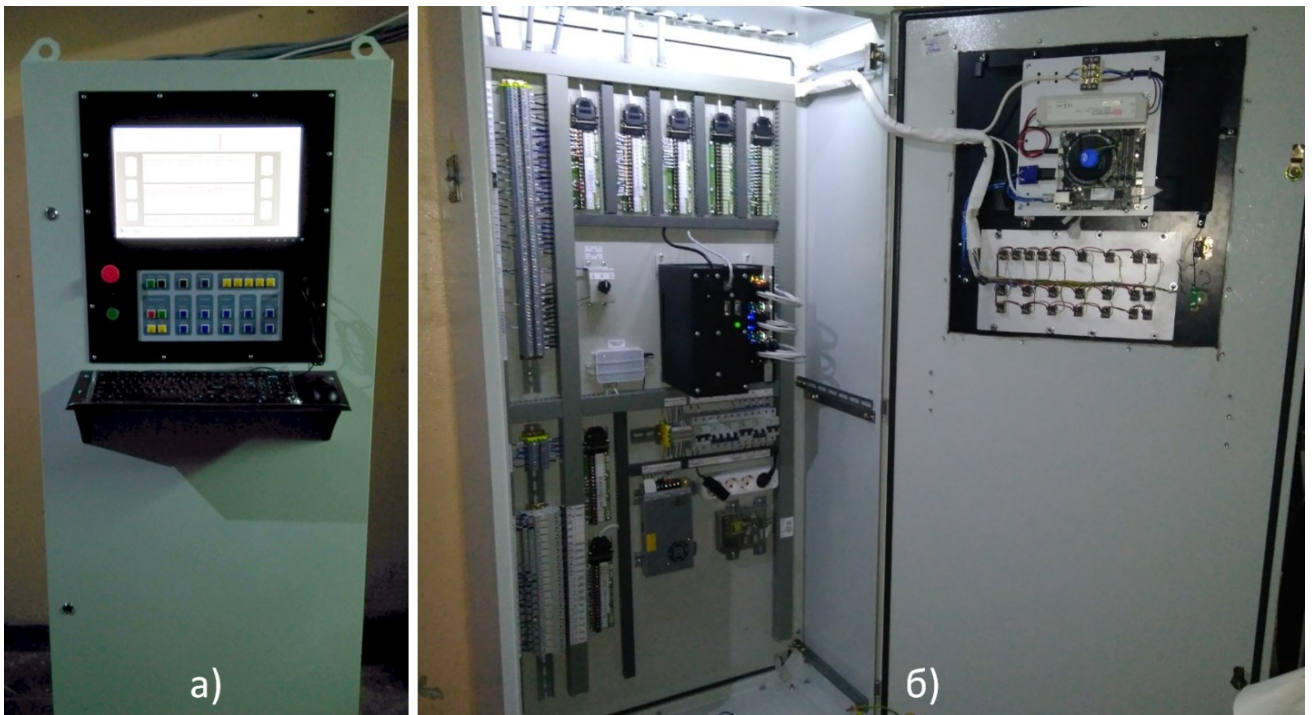
Рисунок 5.47 – Зовнішній (а) та внутрішній (б) вигляд стійки системи ЧПК
