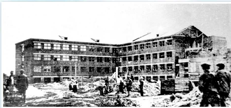
Будівництво у Помірках головного навчального корпусу загальною площею 12 882 м 2 , 1931р.
