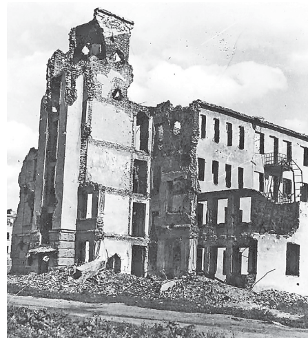
Разрушенное фашистами общежитие
